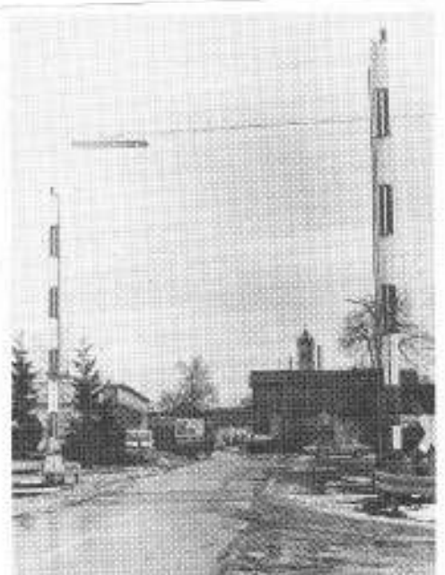
Die Schranken in Türkheim werden abgebaut. Bild: un
