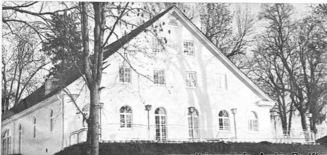
Der Blick auf die Terrasse an der Südseite des Cafés.
