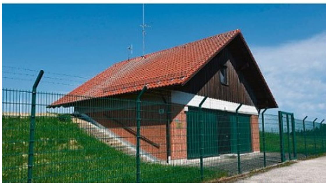
Der größte und älteste Hochbehälter des Staudenwasser-Zweckverbandes bei Siebnach wird im kommenden Winter generalsaniert. Foto: Walter Kleber
